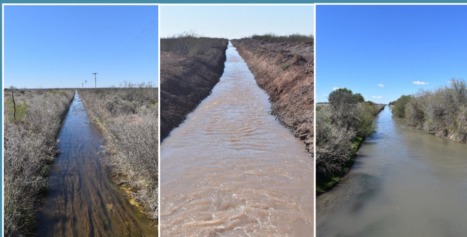
Tareas de campo. Visita a canales de drenaje de los sistemas Valle Verde, 25 de Mayo y Peñas Blancas
